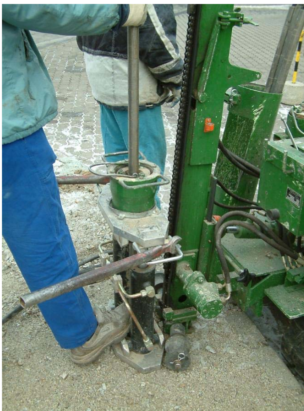
7. ábra: A munkát automatikus, pofás szorítóval felszerelt hidraulikus kihúzóberendezés segíti
