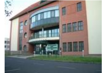
Balassa Kórház Műtöbökk minősített tűzjelző, hangosító rendszer, strukturált hálózat, videómegfigyelő
